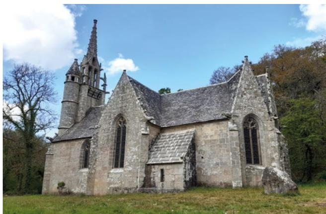
Les travaux de rénovation et d'entretien de la toiture de la chapelle sont terminés. Il s'agissait en particulier de changer une grande partie des tuiles faîtières, de changer les ardoises cassées et de remplacer les man-
